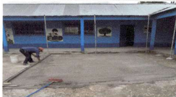
Foto 6: Realizando el trabajo de sustitucion de piso
