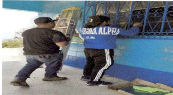
Foto 2: Instalación de vidrios
