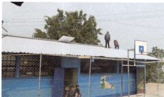
Foto 1: Sustitución de lámina canalada por lámina troquelada
